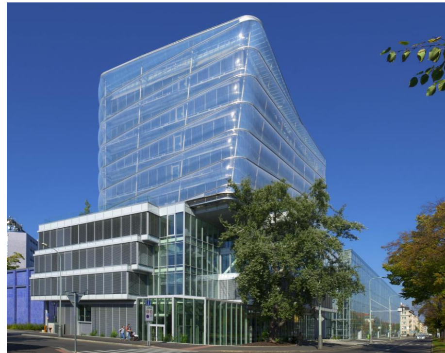
Budova Národního centra Průmyslu 4.0 je součástí ČVUT. Právě zde vzniká mnoho skvělých vychytávek a pomůcek dnešní „doby rouškové“
